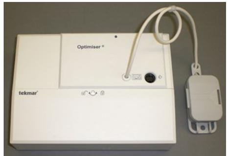
Wenn der Optimiser bereits ab Werk mit abgesetzter Bedieneinheit bestellt wurde, befindet sich im Regler-gehäuse statt des Bedienteils eine Blindplatte mit Anschlusskabel und Klemmdose. Die Klemmdose wird auf der Wand befestigt und das Kabel von der abgesetzten Bedieneinheit hier angeschlossen. Wenn die abgesetzte Bedieneinheit bauseitig nachgerüstet wird, muss zunächst das vorhandene Bedienteil ausgebaut werden. Dazu schiebt man eine
