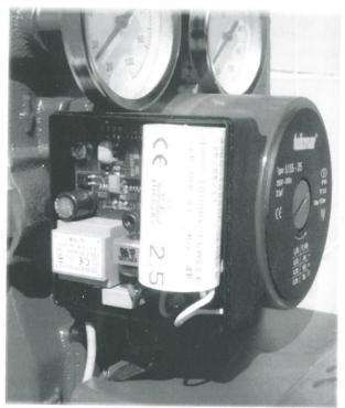
Grundlage für die Funktion der Schnittstelle ist die Einschaltdauer eines Stromsignals von etwa 3,5 mA, der vom Heizungsregler in die Elektronik der Umwälzpumpe eingespeist wird. Basis für die nachfolgenden Erklärungen zum Einfluss des Schnittstellenstroms ist die mit dem Stellknopf an der Pumpe vorgewählte Förderhöhe.
